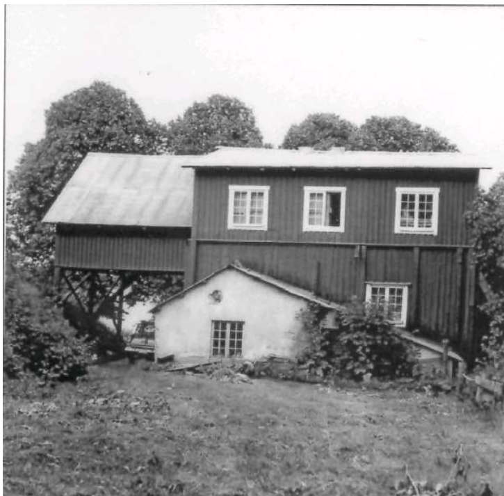
Fotografi från 1950-talet, föreställande kvarnbyggnaden som brann ner 1980. Bilden visar fasad mot sydväst.
